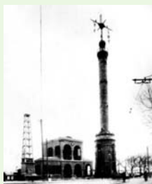
1906年：建造的混凝土信号塔，塔高36.8米，铁杆高12米（总高约50米）
