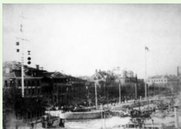
1884年：外滩信号台建成，开始提供天气报告和授时服务。信号塔初建时使用木杆悬挂风暴信号（高：15米）
