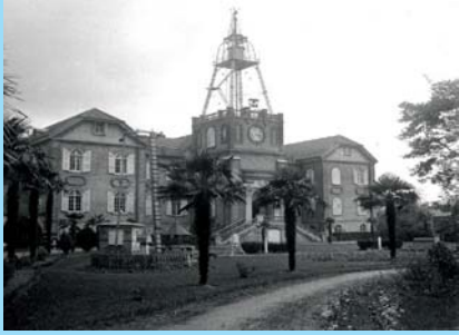
1910年徐家汇观象台铁塔，高35米，顶端安装贝克莱风速仪。
