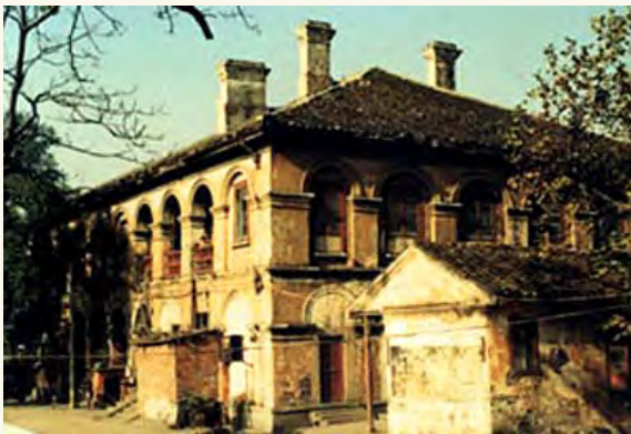
图1 岳州海关及测候所旧址
