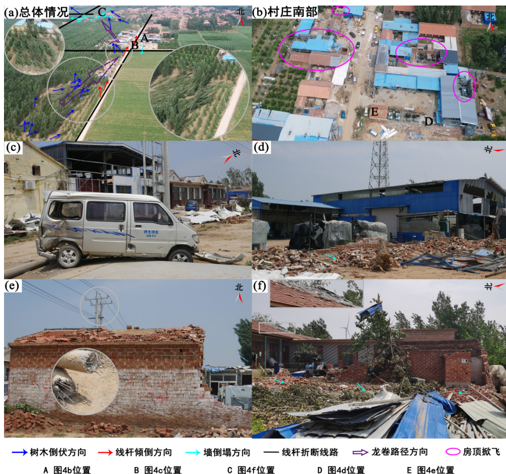
图4 2021年7月11日河北省临西县卢庄村龙卷灾损情况
